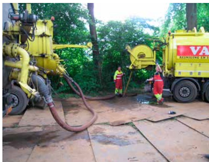
Inspectie stamriool Zandweerd (2014)
