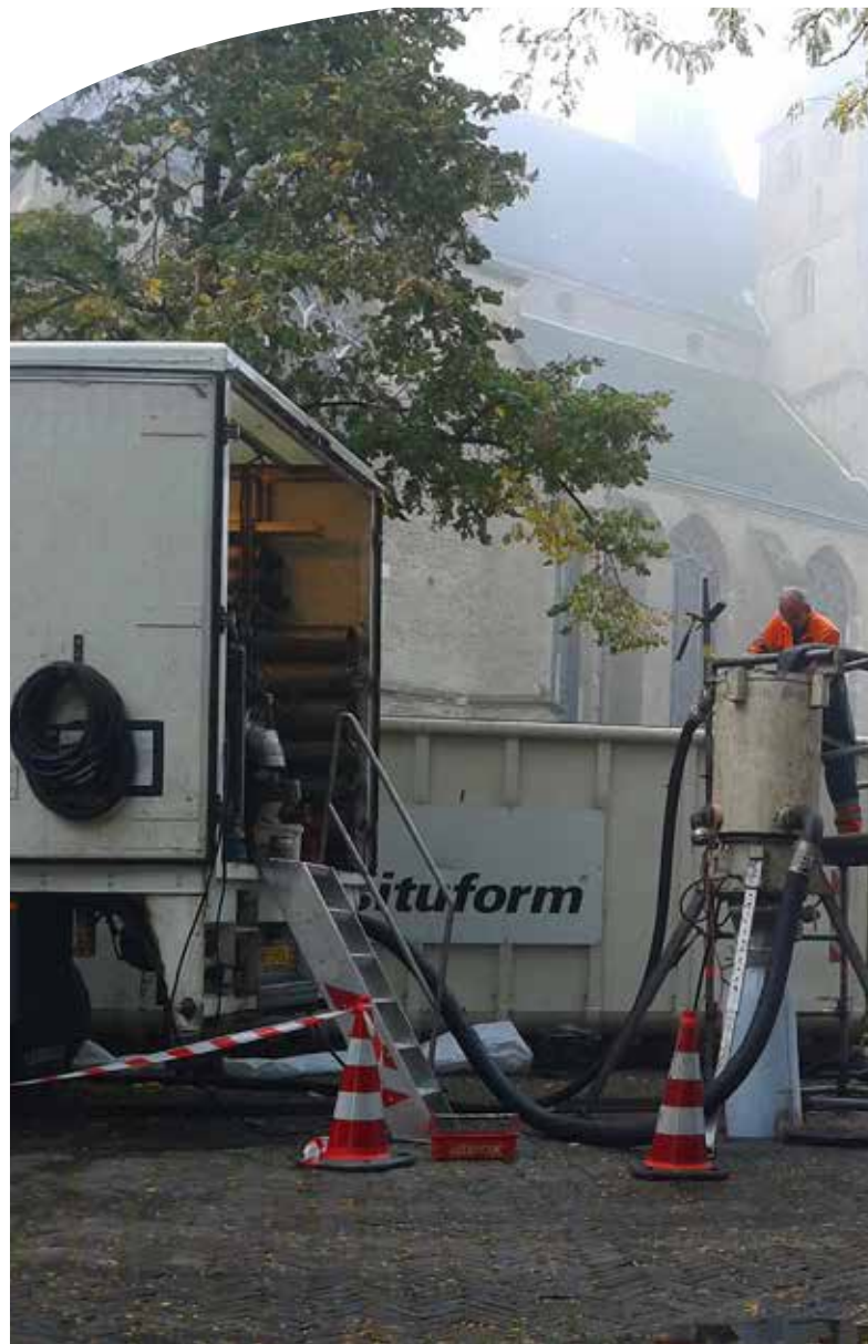
Relining riool Bergkerkplein (2014)
