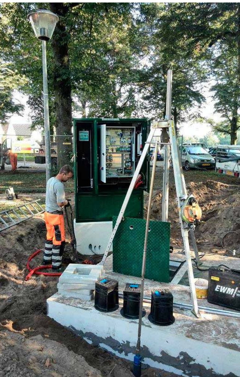
Vervanging gemaal De Worp (2014)
